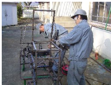
塗装前の錆落とし
