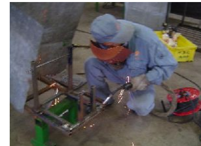
エンジン固定用ジグの仮留め
